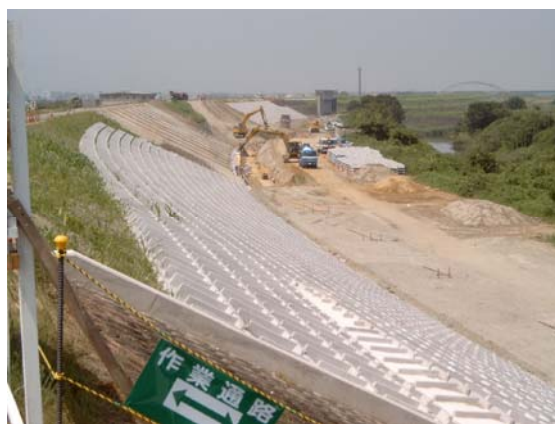
일본 요시노강 만곡 수충부에 진행중인 호안공사 Use of close-to-nature concrete blocks for revetment in Yoshino River, Japan
