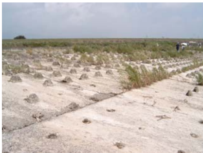
콘크리트 표면의 조도를 높이기 위해 돌기를 만들어 주었다
